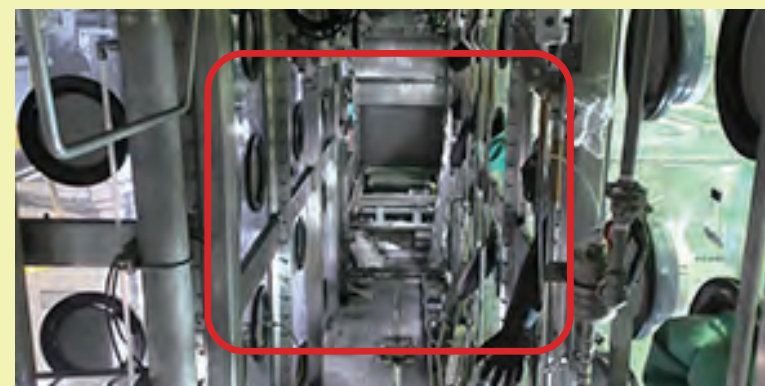
内部機器撤去後
