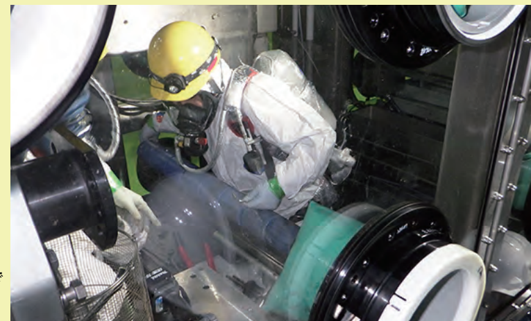
化学防護服 + 空気呼吸器での作業
