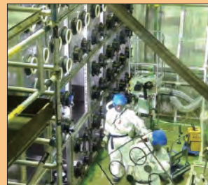
パネル取外し
