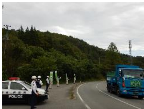
走行状況確認(国道114号)
