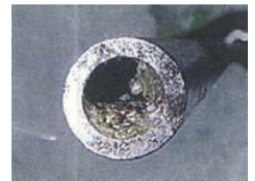
スラリー投入管先端部の閉塞状況
