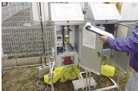
周辺環境(大気)測定装置(エアサンプラー)
