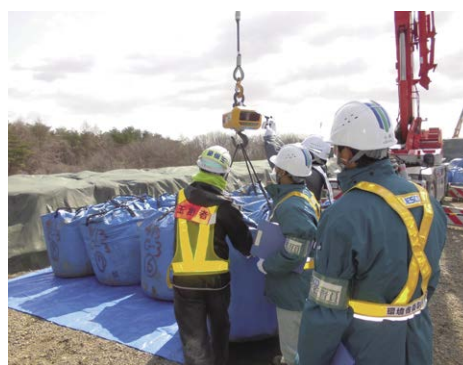
仮置場からの積み出し工事の様子
