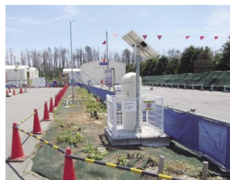
保管場におけるモニタリング装置
