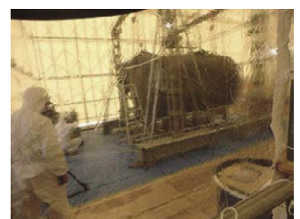
地下埋設タンク切断作業
