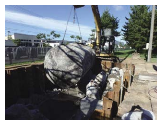
地下埋設タンク取り出し作業
