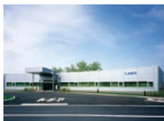
PCB処理情報センター外観
