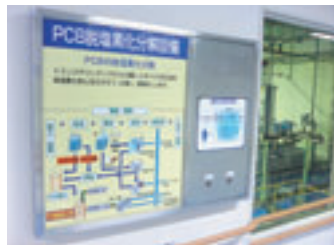
PCB液処理設備
