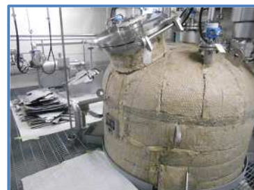
保温材撤去前のタンク
