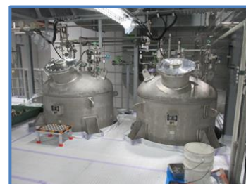
保温材撤去後のタンク
