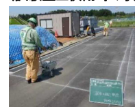
（アスファルト舗装品質確認状況）
