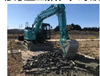
（アスファルト舗装解体時の状況）
