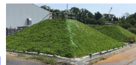
（試験盛土供用時の状況）
