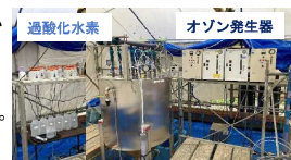
写真1 実証試験状況
