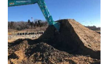
（試験盛土解体時の状況）
