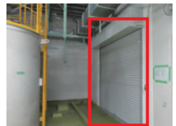
開口部(シャッター)設置後
