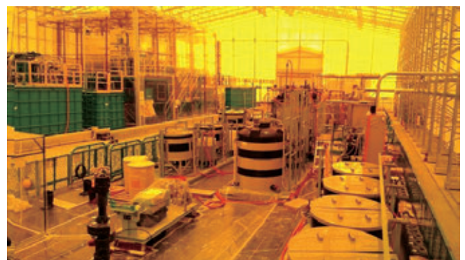
飛灰洗浄処理技術等実証施設の建屋内
