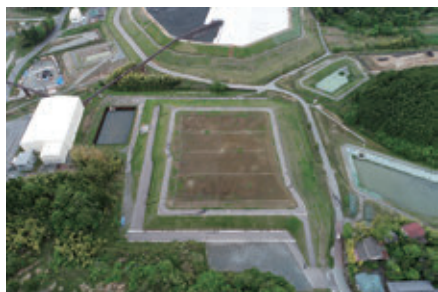
双葉①工区 東側 (2023年5月)
