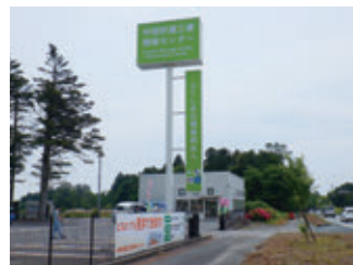
中間貯蔵工事情報センター外観
