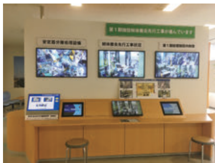
北九州PCB処理事業所 情報公開ルーム（解体撤去工事情報）
