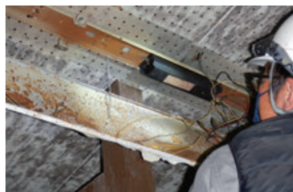
照明器具現地確認作業
