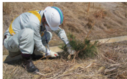
堰堤に生えた樹木の除去
