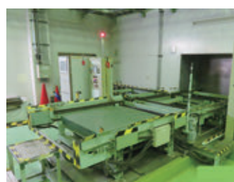
粗解体室のコンベア撤去前
