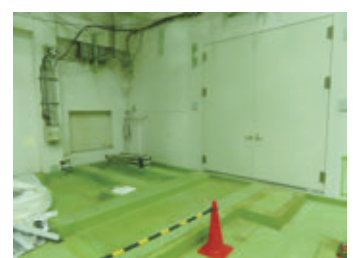
粗解体室のコンベア撤去後
