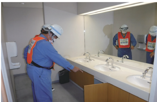
(水回り設備のパトロールの様子)
