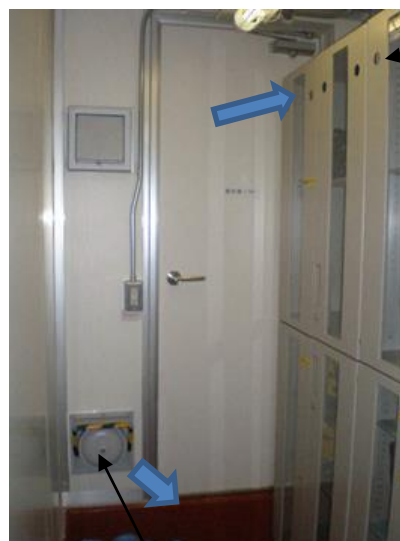
更衣室と緩衝室間にダンパー増設
