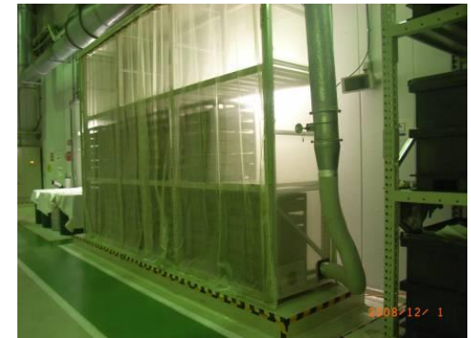
コンデンサ解体・部材置棚 24
