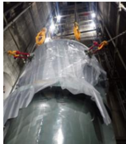
図 地下からの吊り上げ作業
