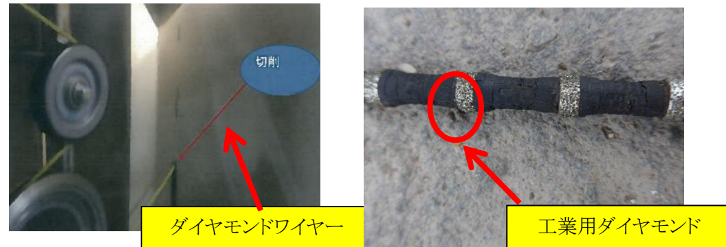
図 ダイヤモンドワイヤーソーを用いた切断
