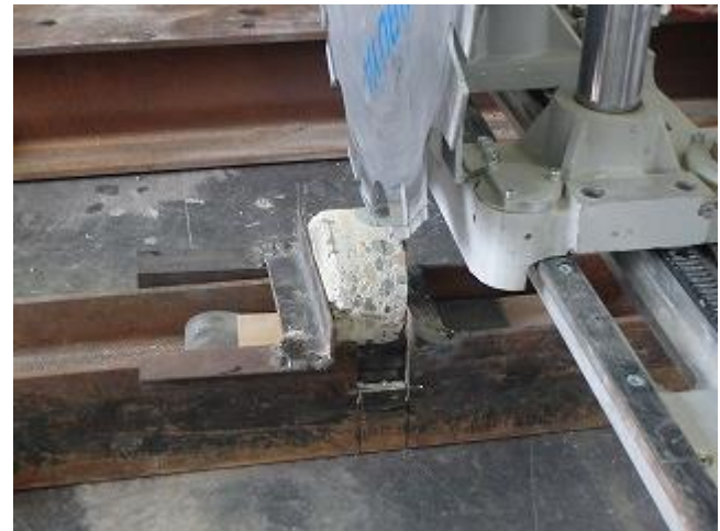
図 コンクリート容器の切断作業 19
