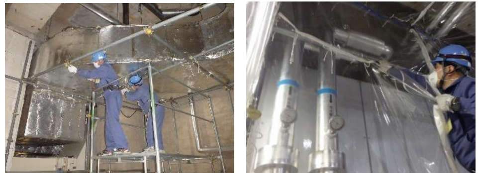
図 グリーンハウス解体作業
