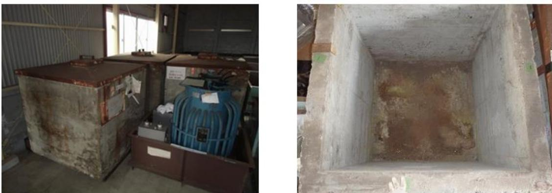
図 2-15 PCB で汚染したコンクリート製構造物
