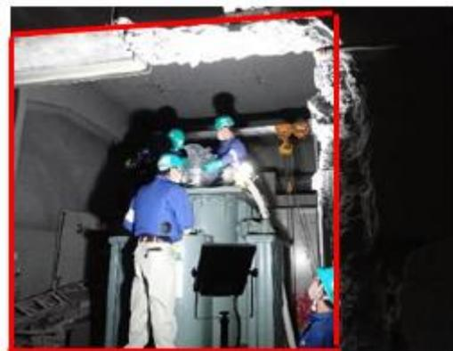
図 2-6 解体作業・搬出のため壁の一部を撤去
