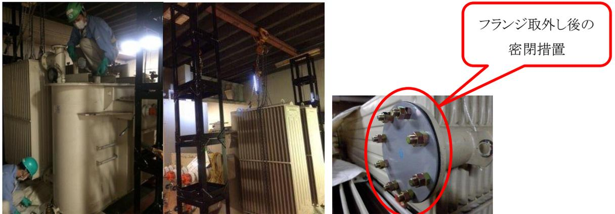
図 2-25 門型クレーンを用いた付属品取外し作業
