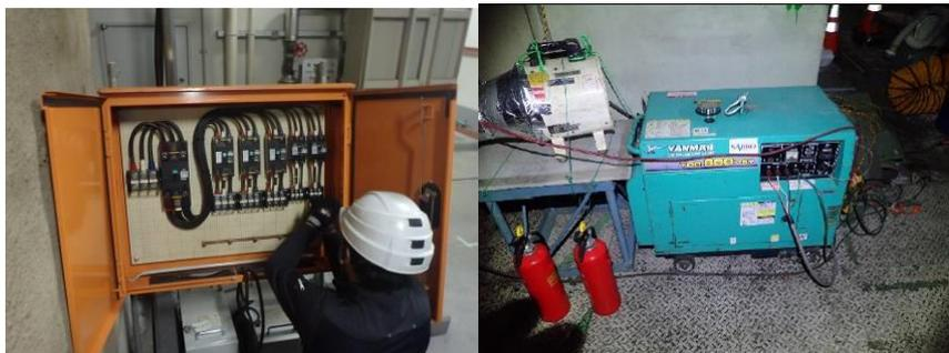
ビル電源を使用できる場合は分電盤を設置（写真左）、できない場合は発電機を持ち込む（写真右）
