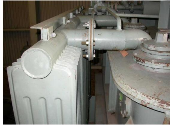
(左：グローブバッグを使用した作業、右：フランジ接続付属品の例としての放熱器)
