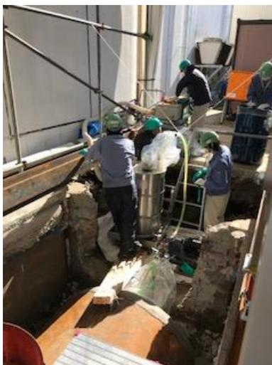
図 2-17 移動型の抜油装置を利用した地下埋設タンクからの抜油
