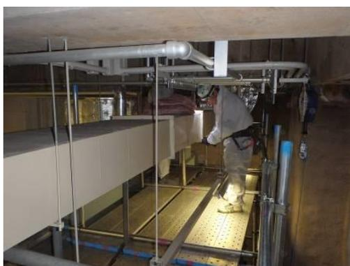
図 2-7 解体作業・搬出のため空調ダクトの一部を撤去
