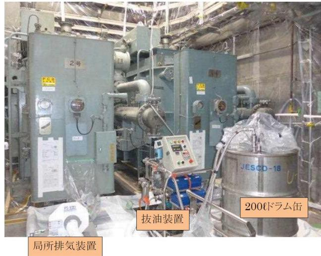
図 2 - 9 抜油作業のイメージ
