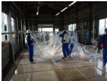
グリーンハウス吊上げ
