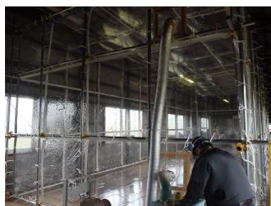
排気用ファン設置
