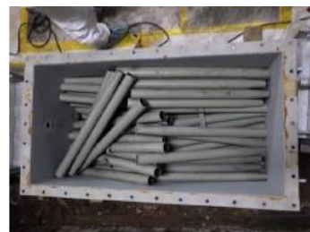
放熱器を切り離し・細断後密閉型容器に収納
