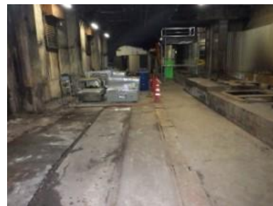
資機材、解体品仮置き場所
