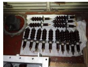
変圧器とリアクトルを接続していたブッシング・リード線を取り外し
