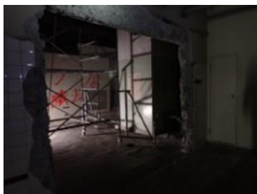
旧電気室の壁の撤去
