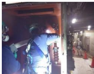
変圧器とリアクトルを接続していたブッシング・リード線を取り外し
