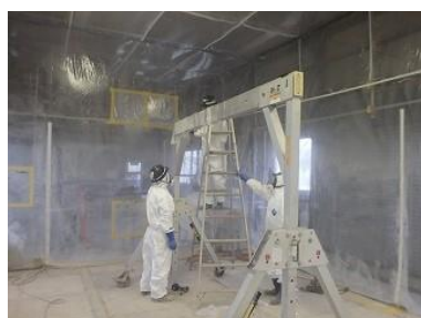
門型クレーン解体
