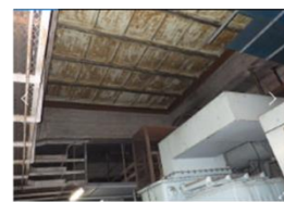
マシンハッチ地下部 (地下に新設電気設備があるため全面開口できない)
