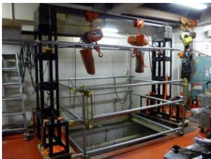
資機材搬入、廃棄物搬出用門型クレーンを特別に製作し設置
