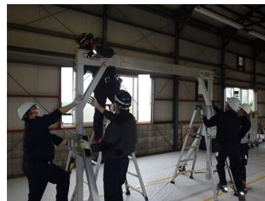
門型クレーン組み立て
