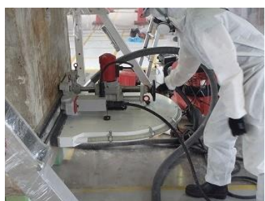
板状への解体
