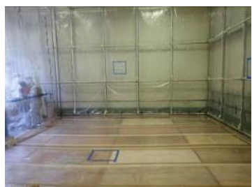
解体作業終了後グリーンハウス内壁面のPCB付着の有無を分析
