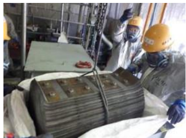
変圧器切断解体物 専用鉄箱 206箱に収納
