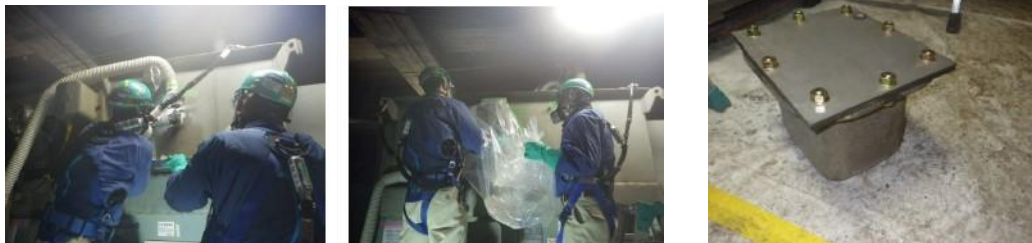
グローブバッグ及び活性炭フィルター付局所排気装置によるPCB飛散防止
