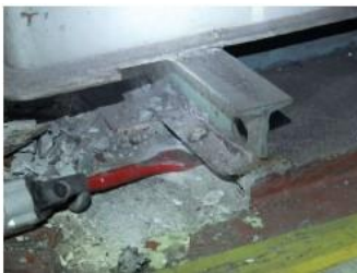
転倒防止のために敷設されていたコンクリート床と固定部分の研り
