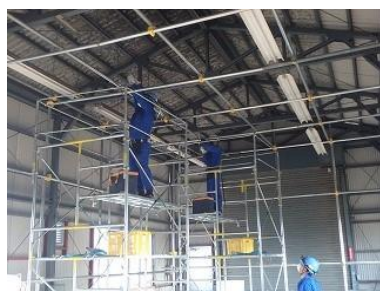
グリーンハウス枠組み解体
