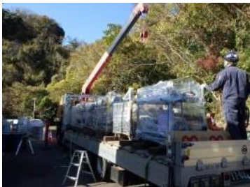
気化溶剤循環抜油装置搬入
