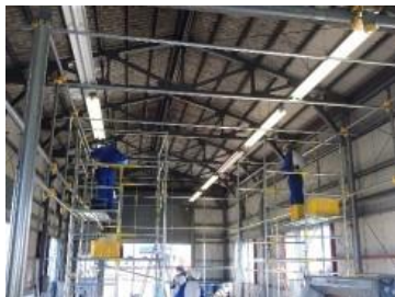
グリーンハウス単管パイプ組み立て
