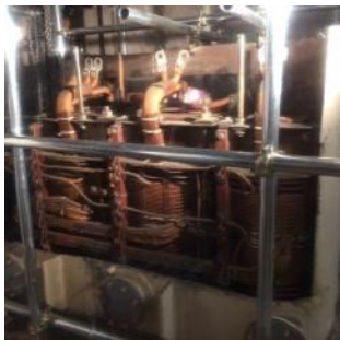
筐体側板切断後
