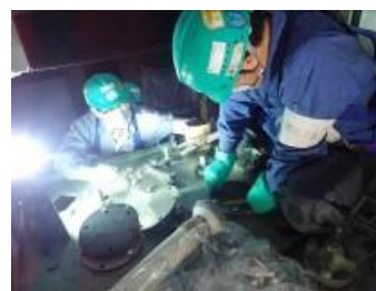
放熱器取り外し
