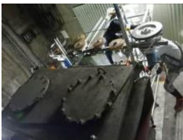
ダイヤモンドワイヤーソーで切断後アルミ板で密閉しベロメタルで補強
