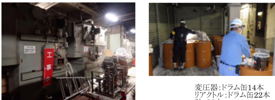
抜油装置による作業
