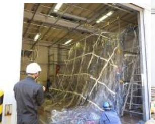
第二倉庫内全体にグリーンハウスを設置
