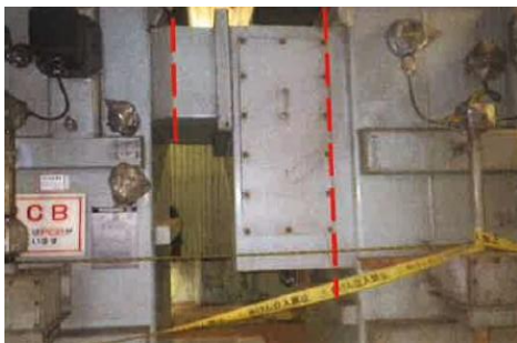
連結部切り離し 変圧器メーカーとの事前調査の結果、ブッシングの保護カバーで液体がない事が判明
