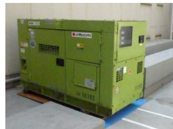
作業用電源確保のため発電機を搬入
