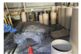
マシンハッチ地上部 (材料等の常時ストック場所となっている)
