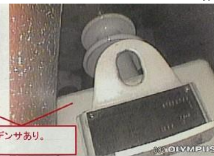
高濃度PCB使用コンデンサー(シバノールの表記)
