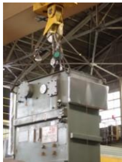
地下通路をマシンハッチ下まで移動後、クレーンで地上に吊り上げ
