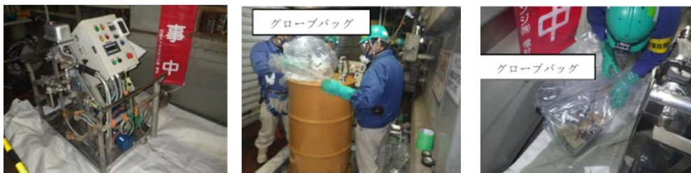
抜油装置による作業
