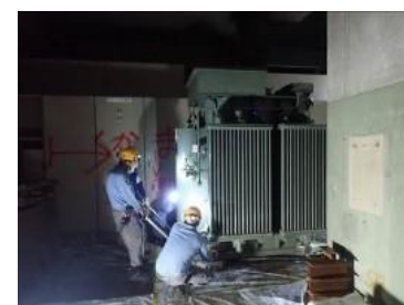
作業場所に変圧器を移動
