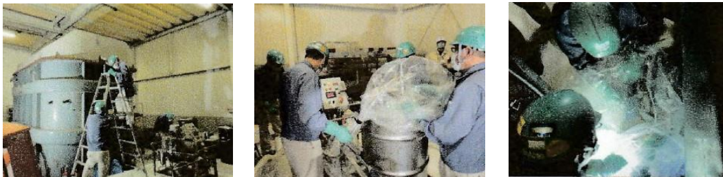
移動式抜油装置による抜油作業。保管事業者により抜油済みとの報告を受けていたが、ファイバースコープによる事前調査の実施により、筐体底部に多量の残油が存在することが判明したため、残油の抜き取り作業を行った。
