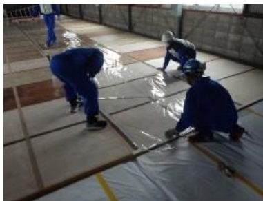
床面補強、養生
