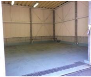
倉庫床面養生
