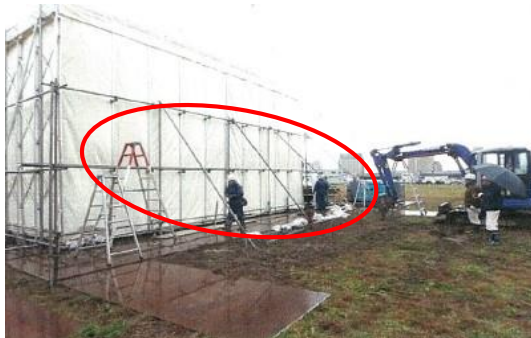
当初予定していた時期より遅れての着工となったことから、季節風対応策としてテントの補強と防風柵を追加設置
