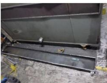
筐体補強をダイヤモンドワイヤーソーで切断
