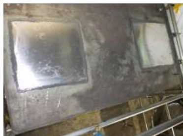
ダイヤモンドワイヤーソーで切断後アルミ板で密閉しベロメタルで補強
