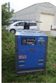
資機材、作業用電源確保のため発電機搬入
