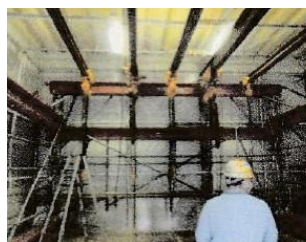
40トン超の下部タンクを吊るため大きなH鋼を使用した可動式クレーンを設置
