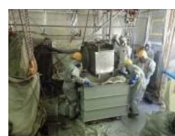
変圧器切断解体物 専用鉄箱 206箱に収納
