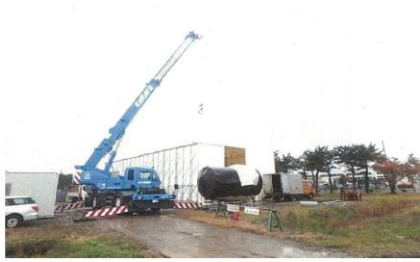
掘り出したタンクを作業用テントまで移動しグリーンハウス内に設置
