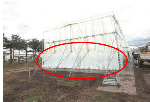
当初予定していた時期より遅れての着工となったことから、季節風対応策としてテントの補強と防風柵を追加設置
