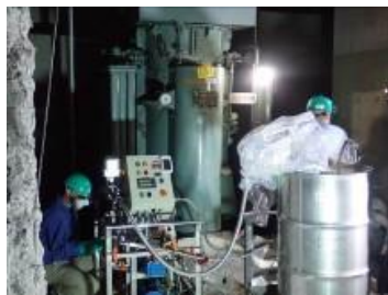
旧電気室から作業場所まで変圧器を移動し残油抜き取り作業
