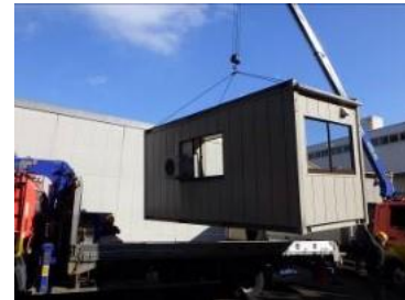
屋外倉庫での作業のため現場事務所兼簡易分析用プレハブ設置
