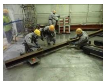
門型クレーン解体
