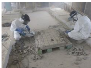
高濃度PCB汚染部分の除去作業
