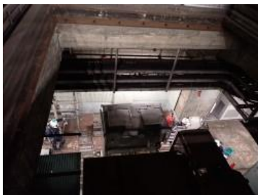
地下通路をマシンハッチ下まで移動後、クレーンで地上に吊り上げ
