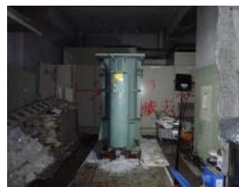
付属品取り外し作業後の筐体
