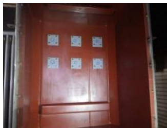
閉止板とパッキンで密閉措置
