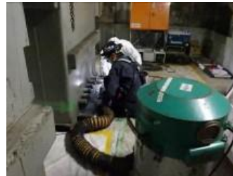
吸引装置によるコンクリート飛散措置
