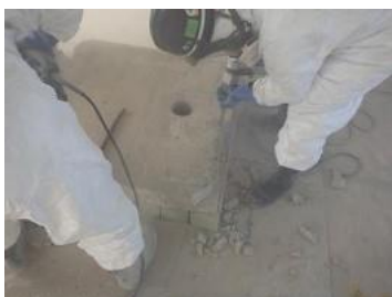
高濃度PCB汚染部分の除去作業
