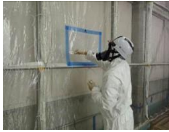
解体作業終了後グリーンハウス内壁面のPCB付着の有無を分析
