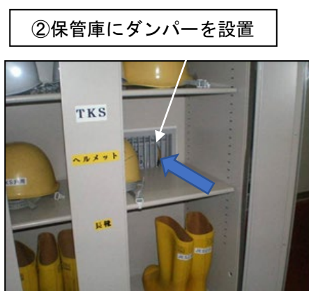
写真 1-8 緩衝室への換気口とダンパーの設置
