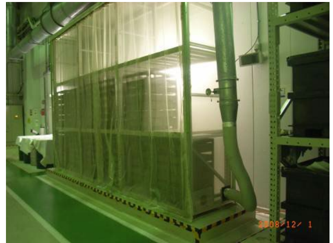
写真 2-8 コンデンサー解体・部材置棚
