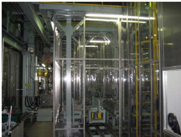
写真 1-3 抜油、蓋切断装置囲い込み
