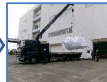
養生・積込み
