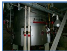
分解槽（解体前）
