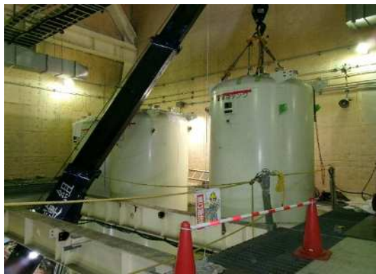
クレーンにて吊り上げ
