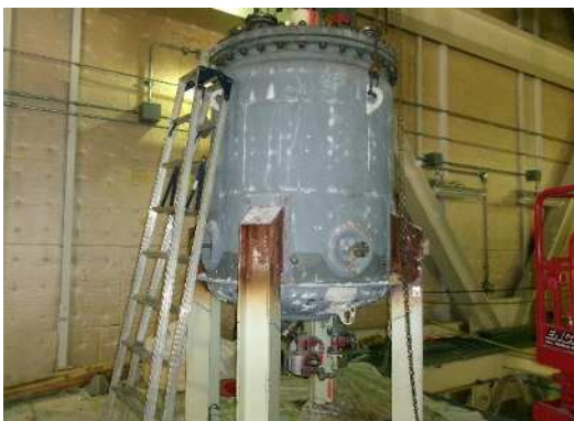
クレーンにて吊り上げ
