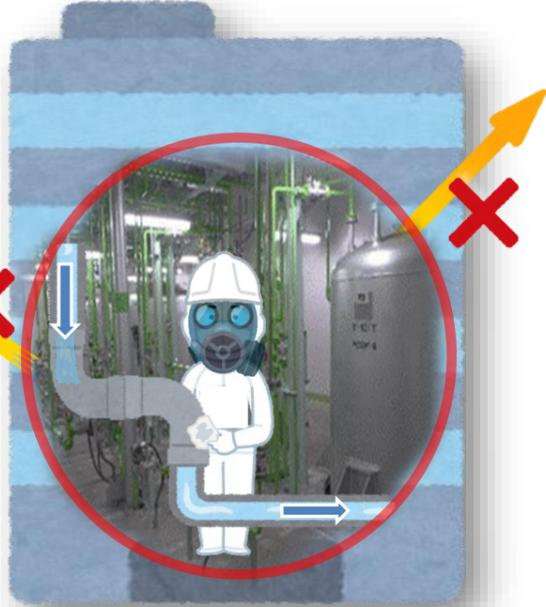
**2** 配管やタンクなどを解体します。低い濃度の PCB がついたものは、鉄箱に入れたり2重に梱包するなどして施設から、処理先まで運び出します。
