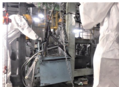
(解体部材は洗浄できる大きさに切断)
