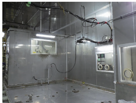
(コンデンサーから自動でPCB油を抜く抜油装置を解体撤去しました)
