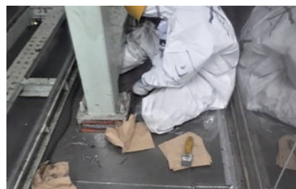
(手作業によるボルト外し)
