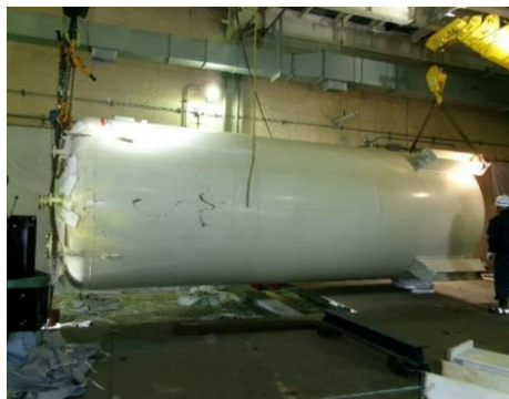
絶縁油タンクの搬出・撤去
