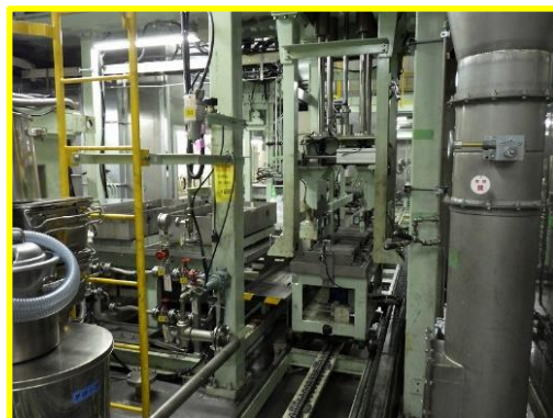
蓋切断装置 移載機
