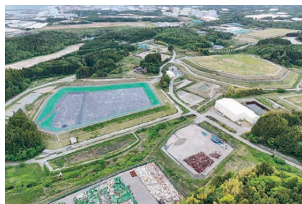
双葉③工区土壌貯蔵施設（2024年5月）
