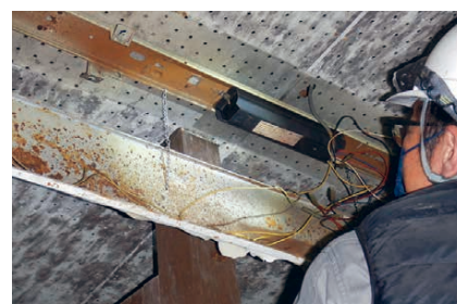
照明器具現地確認作業
