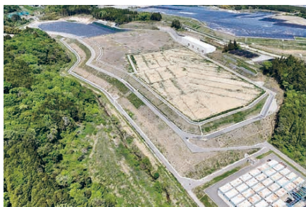
大熊③工区土壌貯蔵施設（2024年5月）
