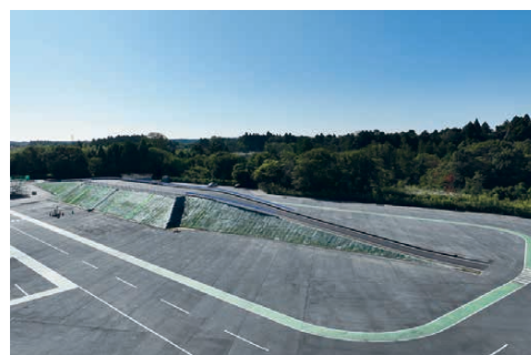
道路盛土の全景（2023年10月撮影）
