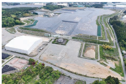
大熊②工区土壌貯蔵施設（2024年5月）
