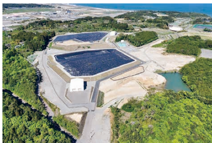
双葉①工区西側土壌貯蔵施設（2024年5月）
