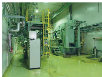
工事開始前の状況
