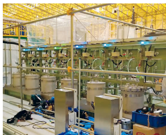
飛灰洗浄吸着試験設備
