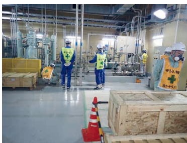
処理施設の設備点検
