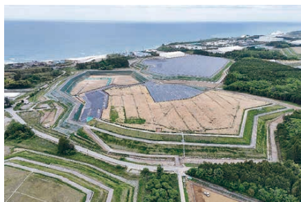
大熊⑤工区土壌貯蔵施設（2024年5月）
