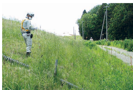
通常点検の様子
