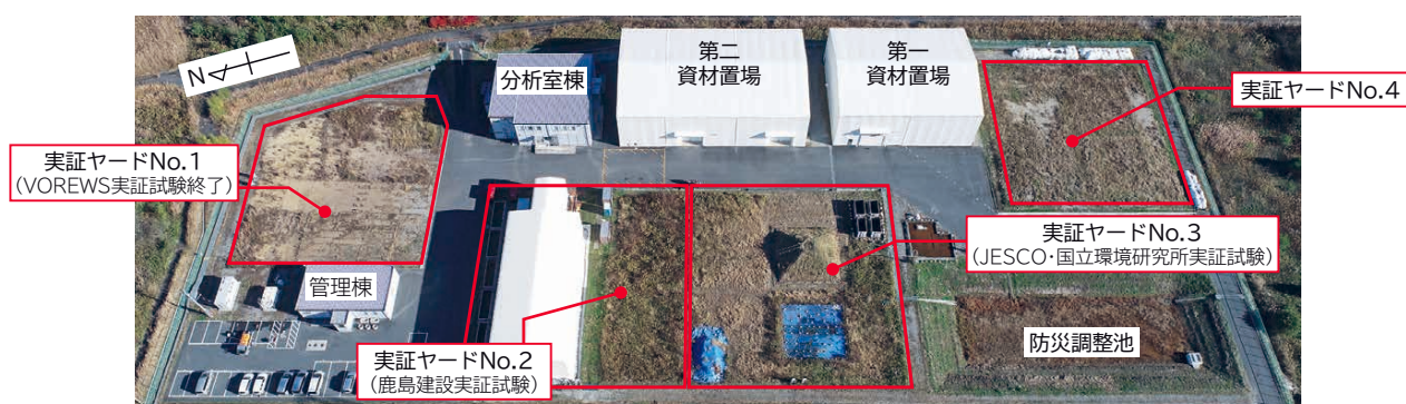
技術実証フィールド全景（2023年12月1日時点）
