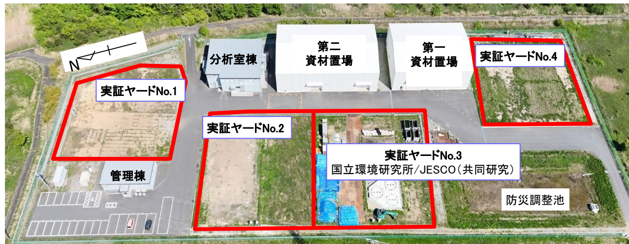
技術実証フィールド全景(2024年5月7日現在)
