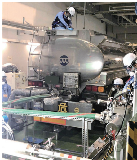
(低濃度PCB油のタンクローリーへの積込⇒)
