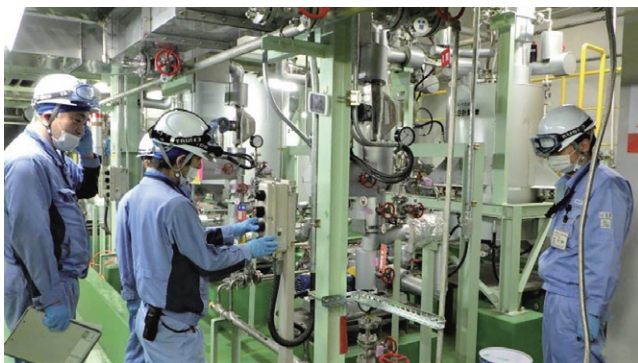
(配管内の洗浄油の液抜き作業)
