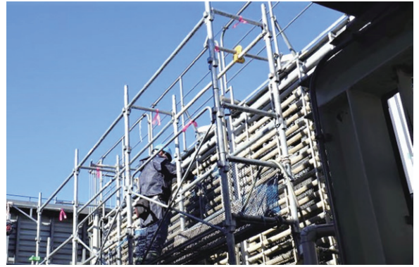
(冷却塔の作業用足場)
