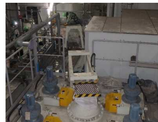
素子回収コンベア 取外し後
