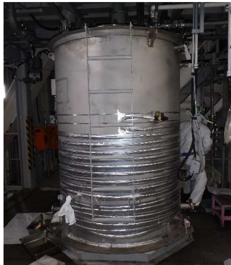
配管類取外し後
