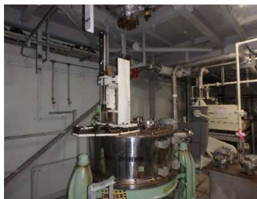
No.1遠心脱油機 配管類取外し後
