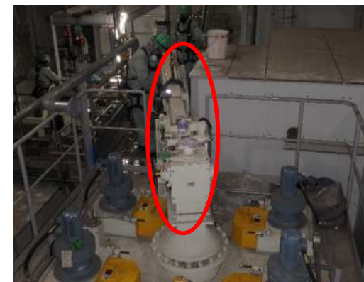
素子回収コンベア 取外し前
