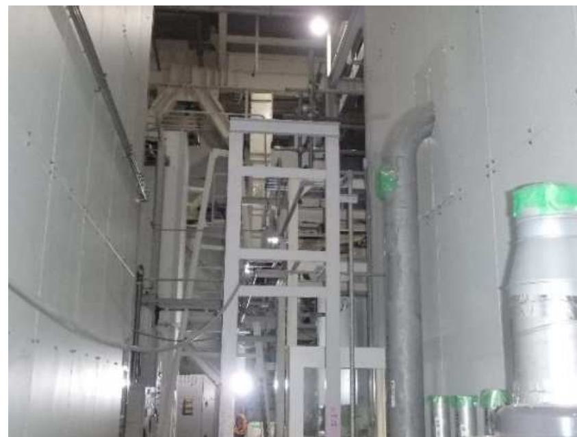
配管類取外し後
