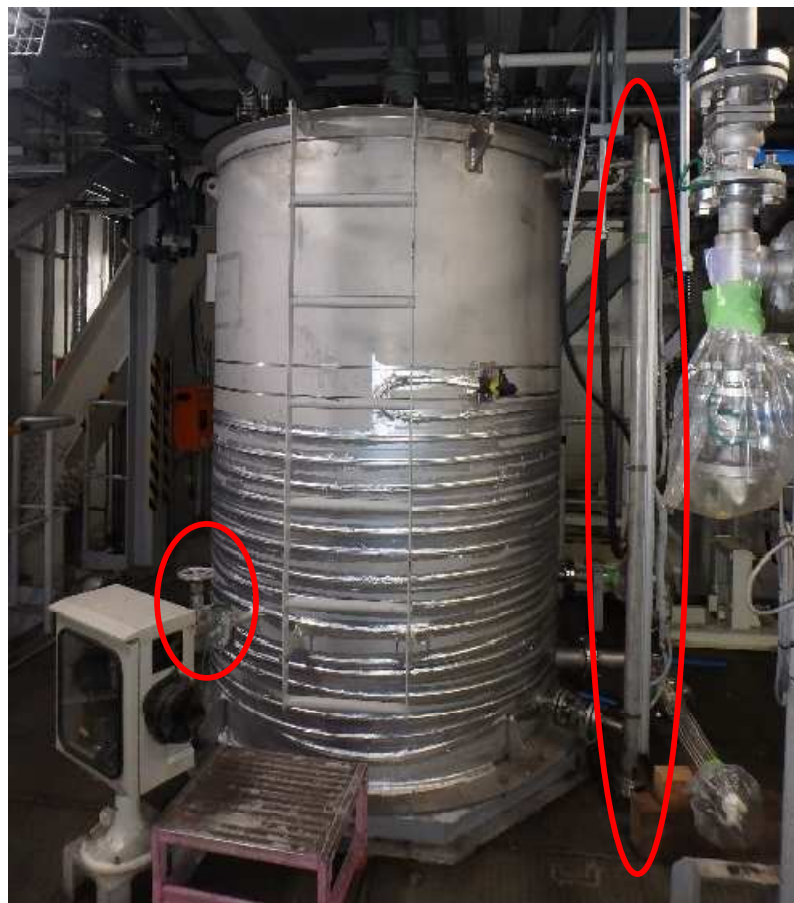
配管類取り外し前
