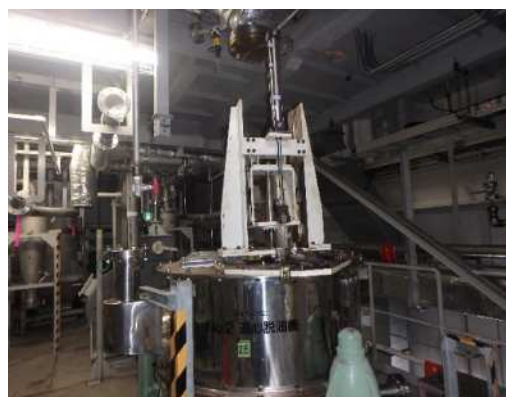
No.2遠心脱油機 配管類取外し後
