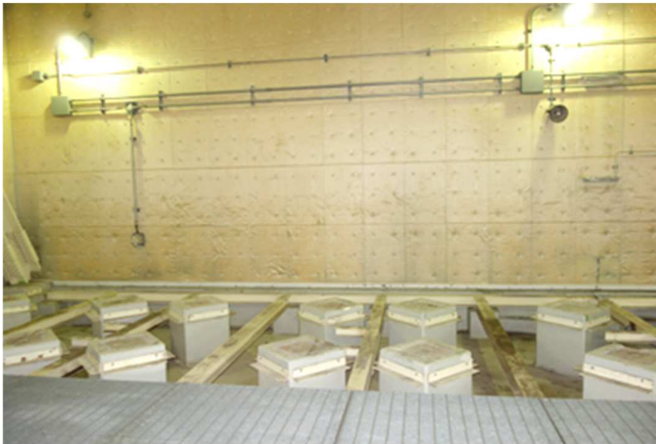
絶縁油タンク3基撤去後
