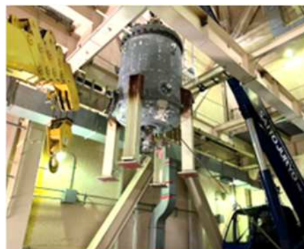
(1Fで解体撤去中)
