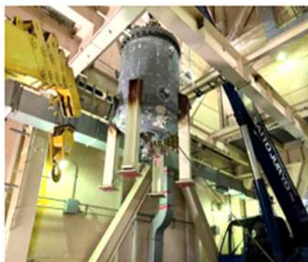
分解槽の撤去(分解室)
