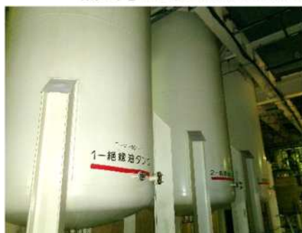
撤去前のタンクの状況
