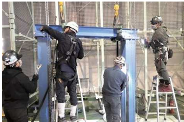
(解体作業の様子)
