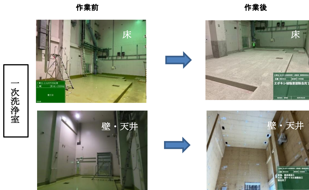
図 11 PCB 除去分別作業（床・壁・天井）前後の状況（次頁に続く）
