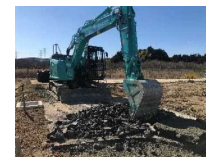
（アスファルト舗装解体時の状況）
