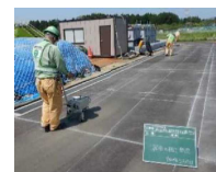
（アスファルト舗装品質確認状況）
