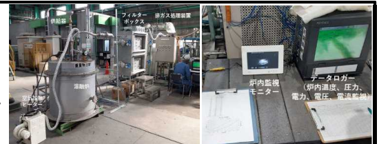
写真1 改造後の試験装置(左)及び監視装置(右)
