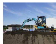
(試験盛土施工状況)
