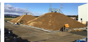
(試験盛土施工完了状況)
