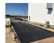
(アスファルト舗装道路)
