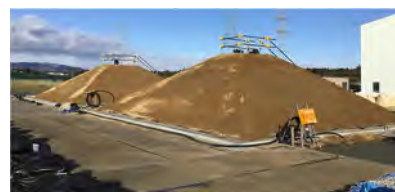
(盛土構築完了)
