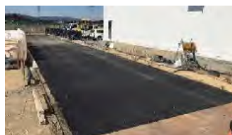
(アスファルト舗装道路 構築完了)
