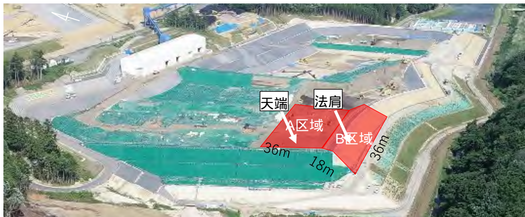
図 2-1 試験区域（大熊 3 工区土壌貯蔵施設）
