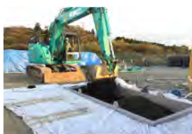
(盛土材製造状況)
