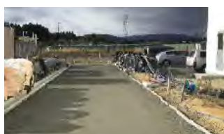
(路盤構築完了)
