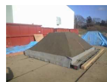
写真-4 実証盛土
