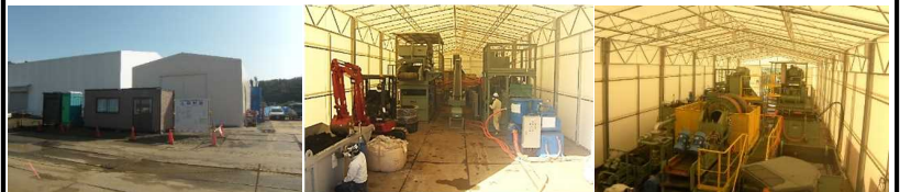
写真-1 実証実験状況(プラント用テント)
