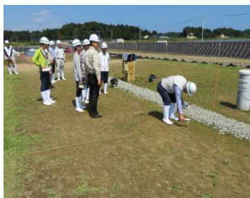
再生利用実証事業施設
