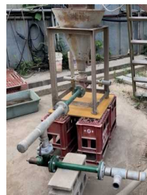
図2 攪拌エジェクター、高圧洗浄エジェクター写真
