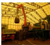
受入・分別施設(1期双葉工区)
