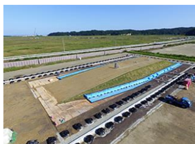
（再生利用実証事業施設）
