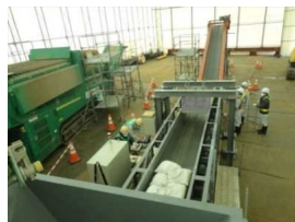
図2 濃度分別装置による現場試験
