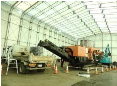
図 3-4 実規模改質試験の状況
