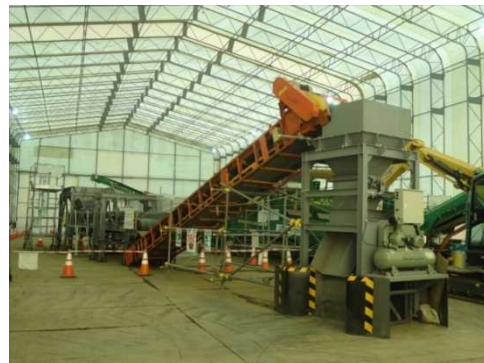
図 3-6 現場試験の状況
