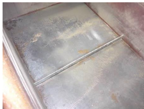
写真 3 シャワーリング後
