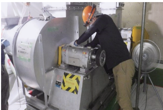
排気ファン軸受けの交換作業の様子
