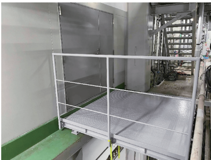
扉、防護柵を設置
