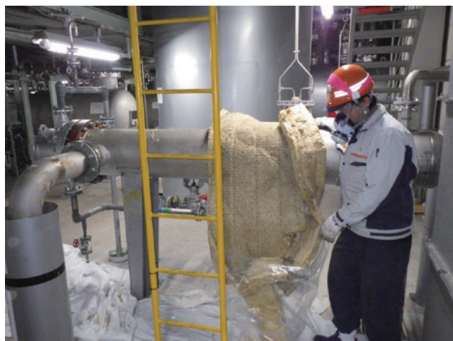
蒸留エリアでの保温材解体撤去の様子
