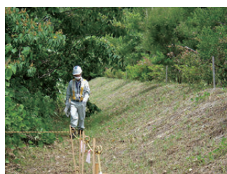
巡視点検の様子
