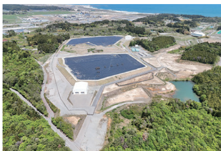
双葉①工区西側土壌貯蔵施設（2025年5月）
