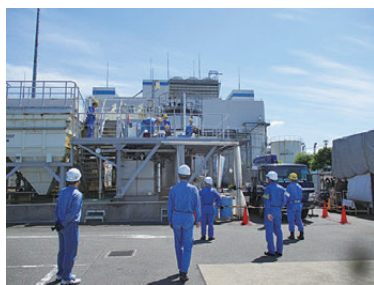
処理施設の設備点検
