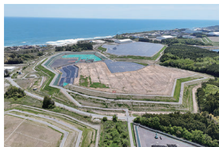
大熊⑤工区土壌貯蔵施設（2025年5月）
