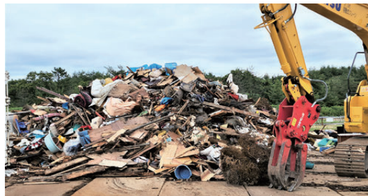
2024年7月3日 輪島市の門前モータースポーツ公園の仮置場 定点観測の写真撮影を実施
