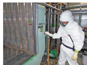
PCB付着状況調査（拭取試験）
