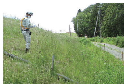
通常点検の様子
