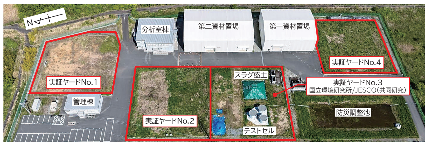
技術実証フィールド全景（2025年5月13日時点）
