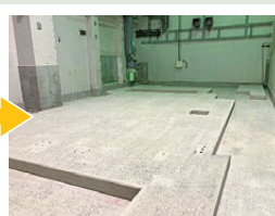
床の除去分別完了後
