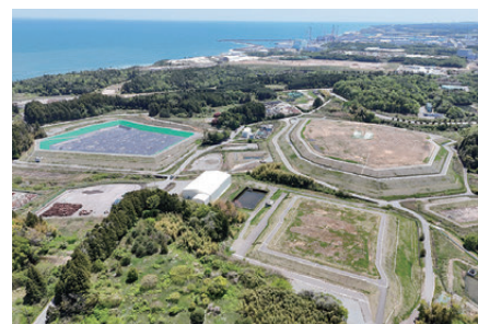
双葉③工区土壌貯蔵施設（2025年5月）
