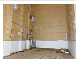
壁の除去分別完了後
