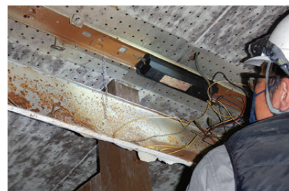
照明器具現地確認作業
