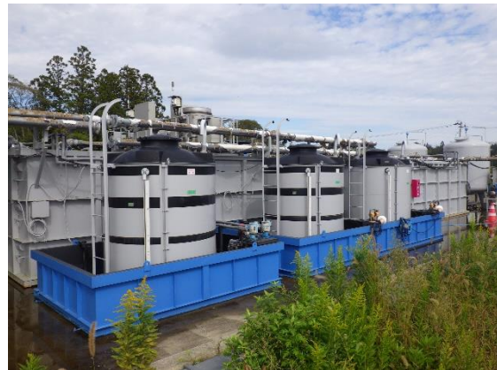
大熊⑤工区浸出水処理施設
