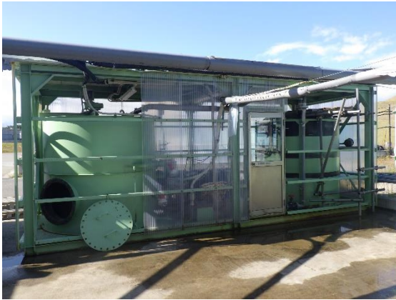
双葉①工区西側浸出水処理施設
