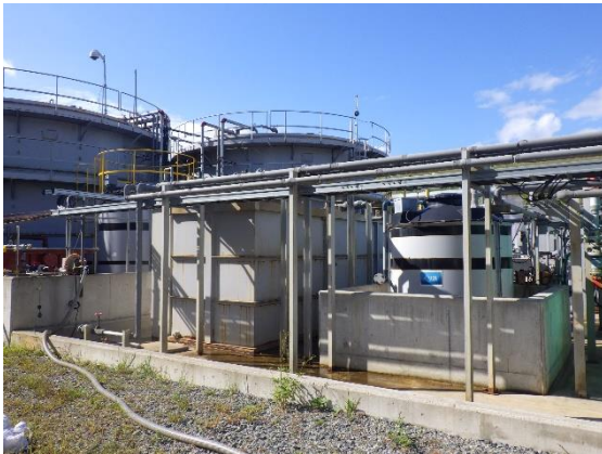
双葉③工区浸出水処理施設
