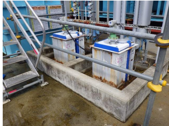
大熊①工区浸出水処理施設
