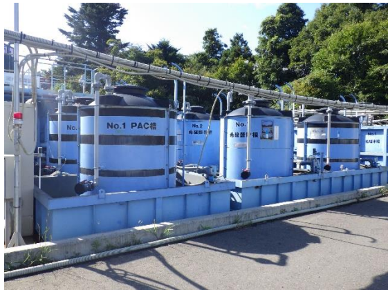
双葉②工区浸出水処理施設
