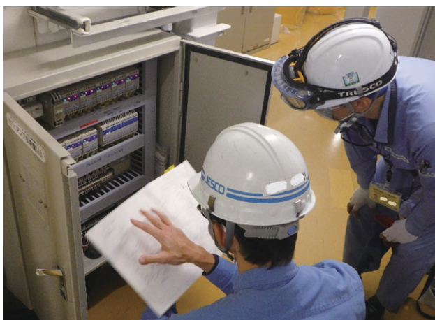
プラント設備の電気離線・解線の作業
