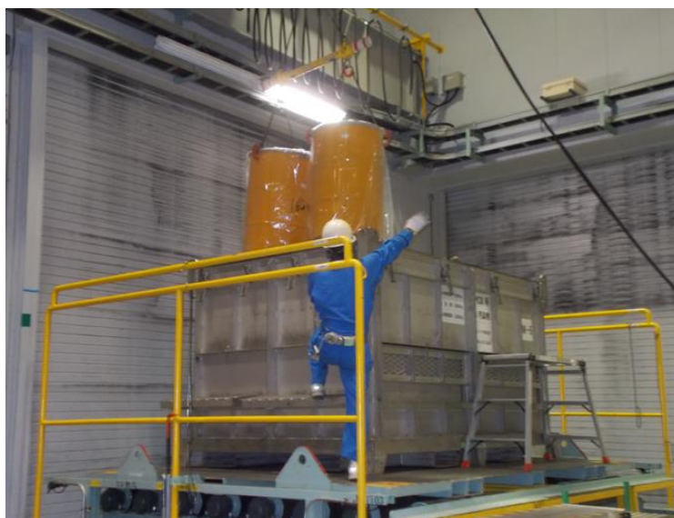
搬送容器から解体撤去物の入ったドラム缶を取り出し
