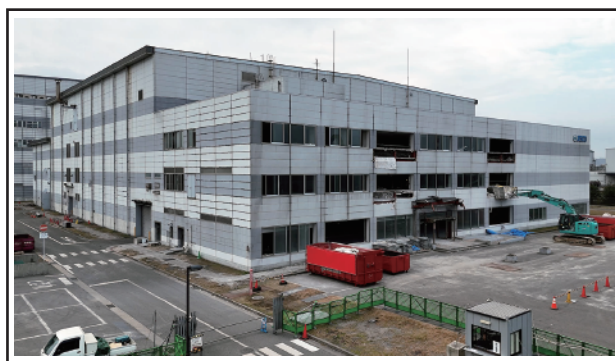
建屋の解体撤去着工後 (2026 年 2 月撮影)
