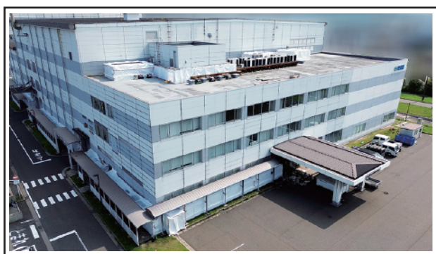
建屋の解体撤去着工前 (2025 年 9 月撮影)
