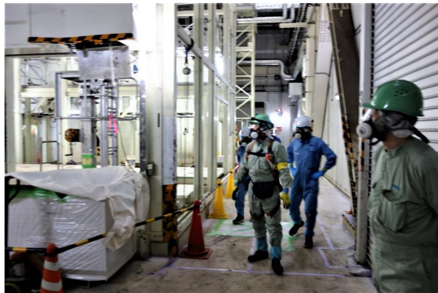
解体撤去災害防止協議会パトロール(1/22)
