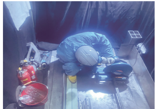
裁断破碎エリア解体中の火気使用作業状況
