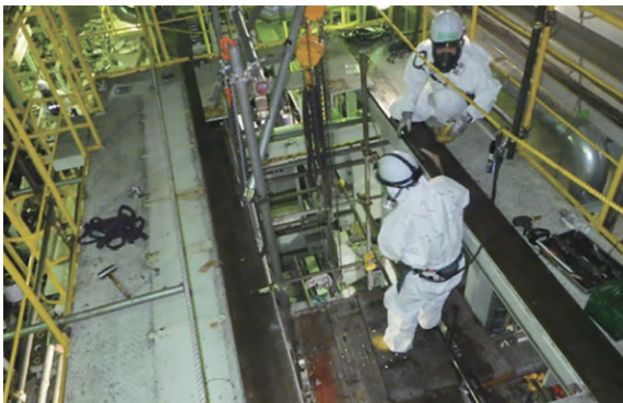
裁断破碎エリア解体中の高所作業状況
